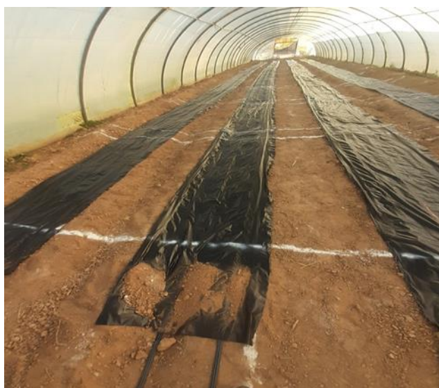
Photo 11: installation le film plastique
