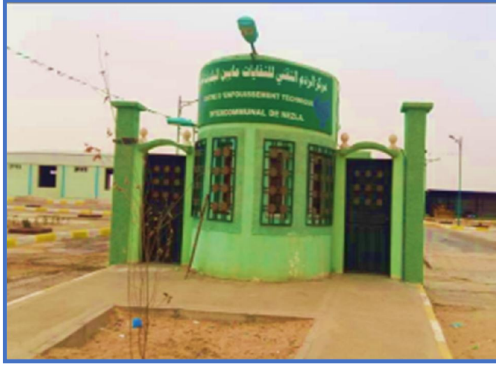
الشكل رقم 9: صورة لواجهة مؤسسة الردم التقني
