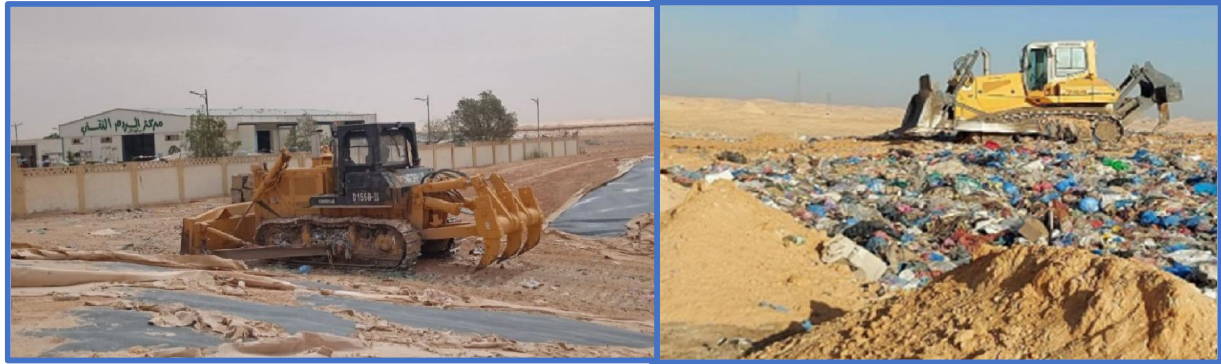
الشكل رقم 13: صورة لمرحلة رص وردم النفايات
