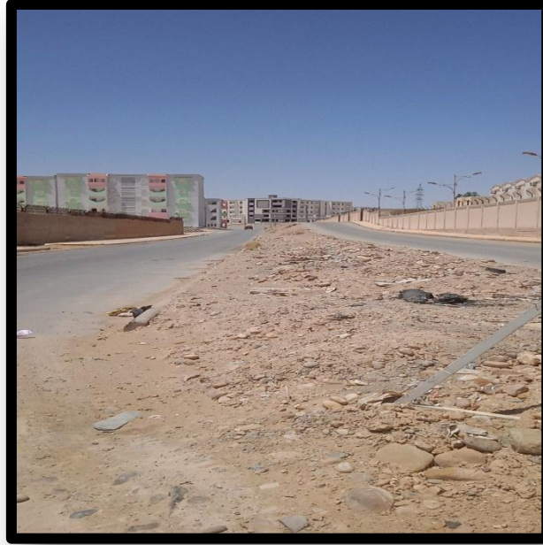
الصورة رقم (16): توضح الطريق الشمالي المحاذاي للحماية المدنية .
