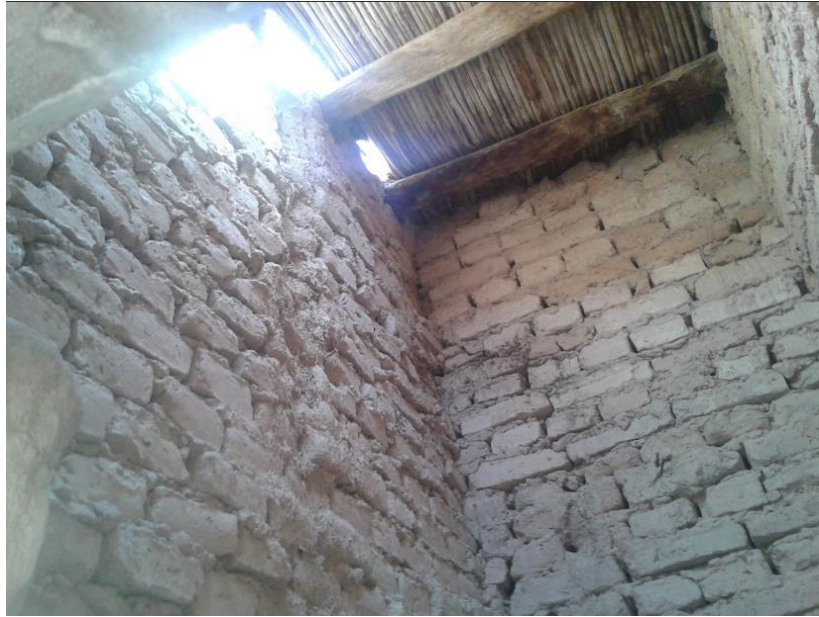
Figure 81: illustration des matériaux utilisés des murs et de Toit. Exemple Maison à Ourel
