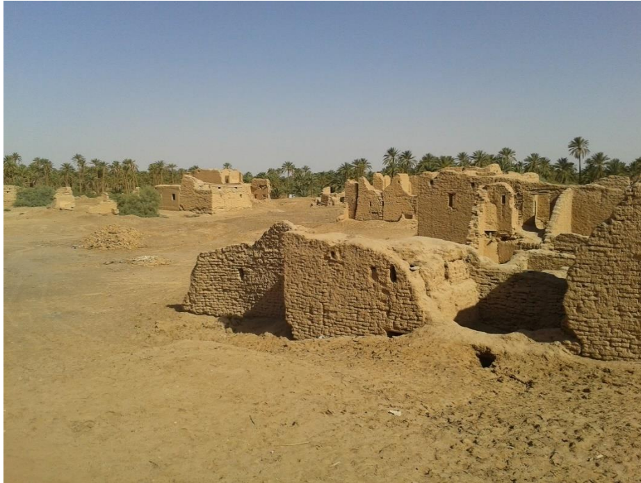
Figure 54: Illustration de l'état actuelle de la plupart des Ksour(exemple Ksar Oumech) source : Auteur
