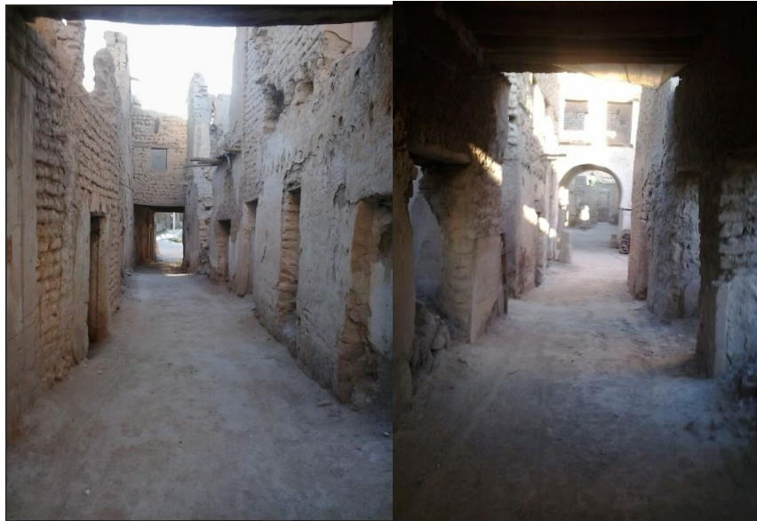
Figure 77: Exemple de Skifa urbaine dans le Ksar de Lichana (Source : Auteur)
