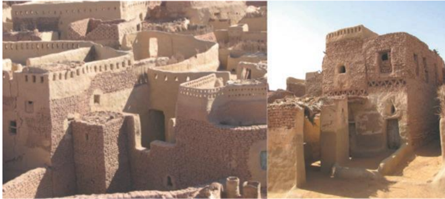
Figure 46: illustration des habitations à Balat intégrant des claustras dans les l'enveloppe extérieure (Omar, 2014)
