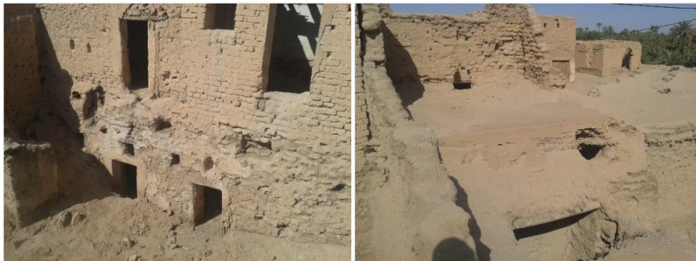
Figure 61: Des vues prises depuis le Ksar d'Ourelal source : Auteur
