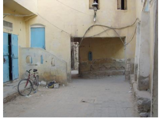
Figure VI. 3: Vue de placette côté Nord- Ouest. Source : Auteur, 2011
