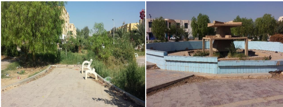
Figure IV. 20: Vues sur a place Iben Badis, source : auteur, 2016
