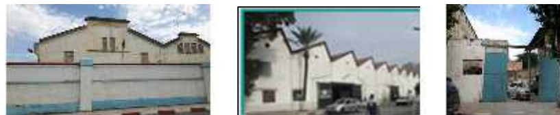
Structures de hangars datant du XIXème siècle, support d'activités commerciales liées à la route.
