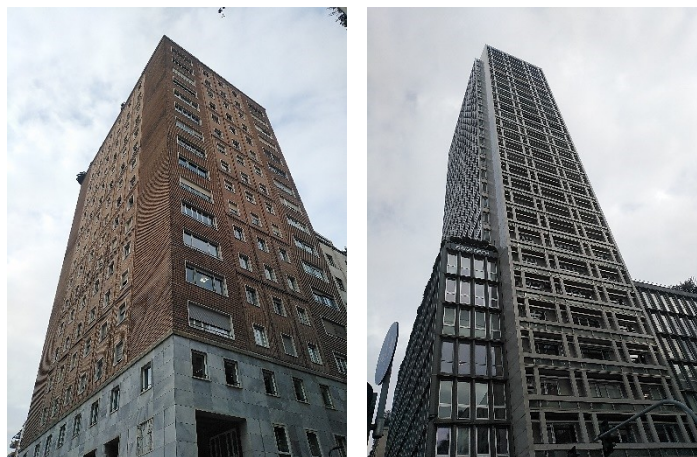
Figure III.12: Fenêtres de l'enveloppe du bâtiment. Source : (l'auteur)
