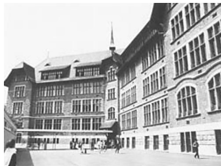
Figure II.3 : Bâtiment scolaire à typologie Heimatstil. Source : (Foster S. et al., 2004).
