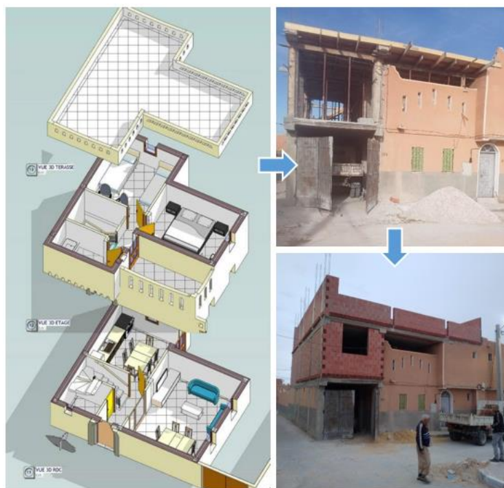
Fig.103 : Nouvelles extensions de la ville d'Ouargla. Un logement LPA cite Bamendil Ouargla. Société de promotion immobilière SOTRAV : changements des plans et façade. Source : l'auteur,2022
