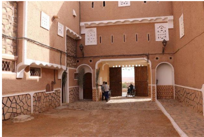
Fig.40. Maison Type Ksar Tafillelt (Ghardaïa). Source : http://portail.cder.dz/spip.php?article5562
