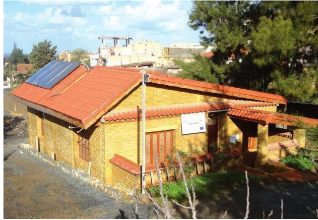
Fig.38 : Une maison pilote bioclimatique à Souidania (Alger). Source : Hamidat, 2016
