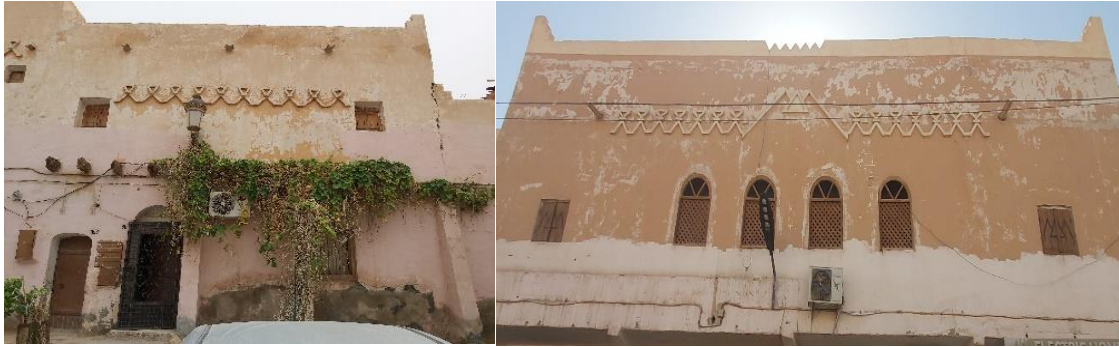
Fig.91: Rénovation d'une partie de la façade urbaine. Source l'auteur 2020
