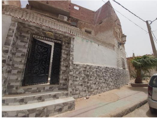
Fig.90 : Transformations de l'image du Ksar par les habitants En construisant des habitations avec de nouveaux matériaux de construction et d'une manière aléatoire. Source l'auteur 2020.
