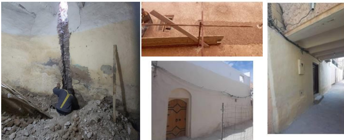
Fig.94 : Maisons restaurées dans le Ksar d'Ouargla, à gauche la photo présente le renforcement de maison par les poteaux, à droite les photos présente la restauration des façades avec l'utilisation des portes traditionnelles avec les arcs. Source : l'auteur, 2020
