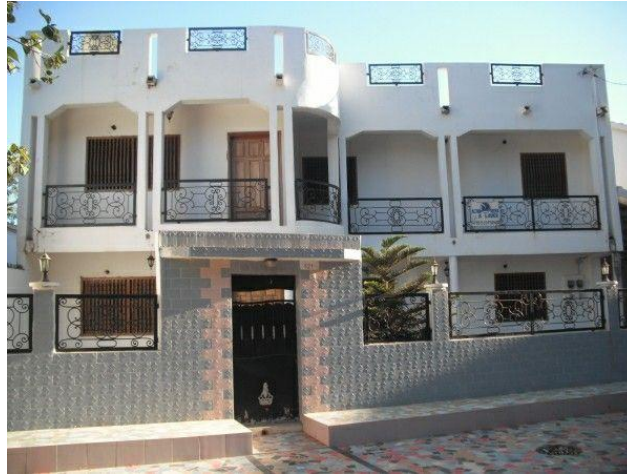
Fig.23 : Habitat individuelle à Alger, Algérie. Source : https://lalgerieaujourd'hui.dz/immobilier-stagne-a-alger .
