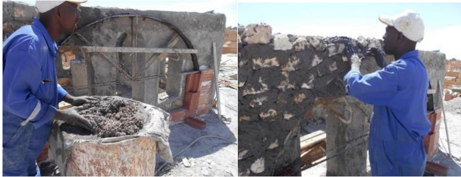
Fig.93 : Formation de maçons sur la construction avec les techniques traditionnelles. Source (Kchired, 2017).
