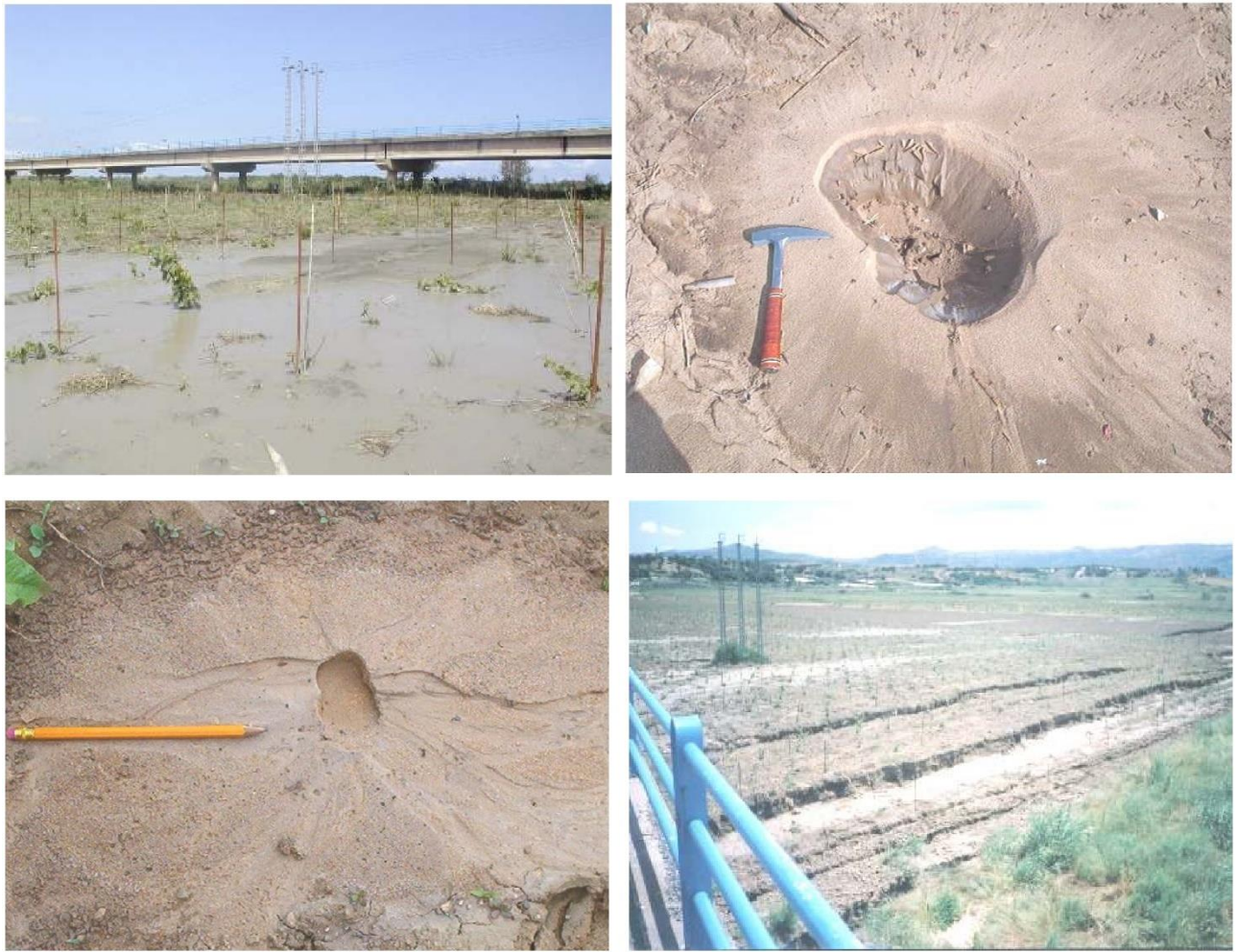
Figure 3.1 - Liquéfaction observée près du pont d'Isser et à la rivière de Sebaou, provoquant des fissures liées au mouvement du sol (Mebarki, 2009)
