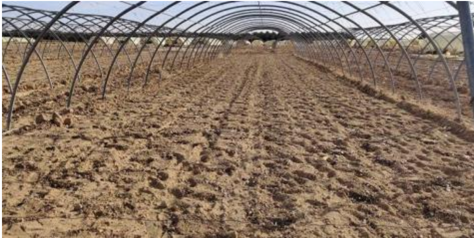
Figure 9 : Installation de la serre (Originale)
