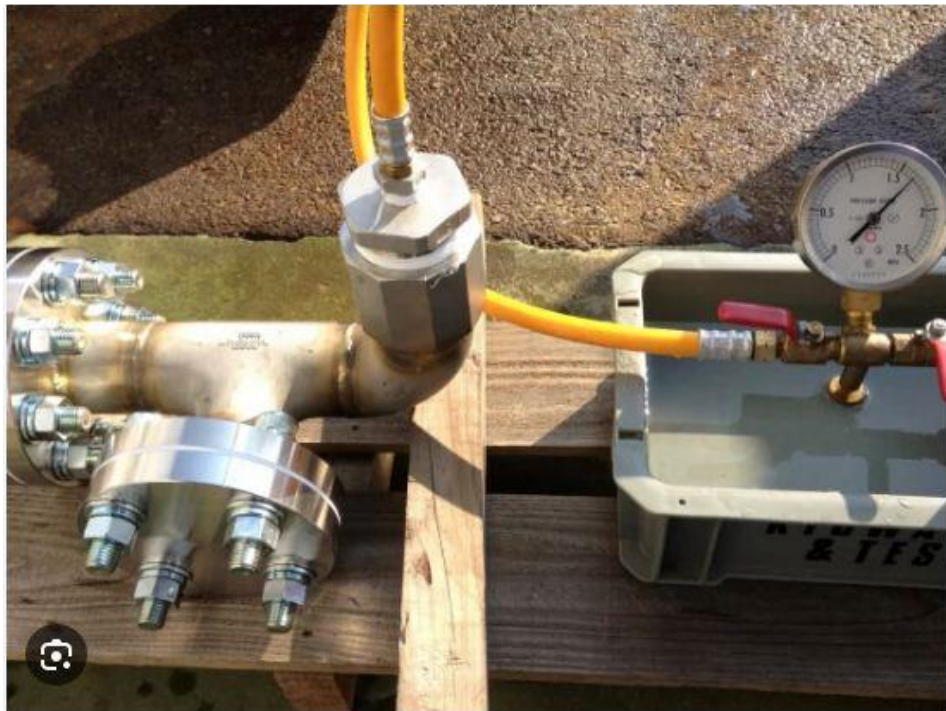
Figure I 39 Essai de pression pneumatique [27]
