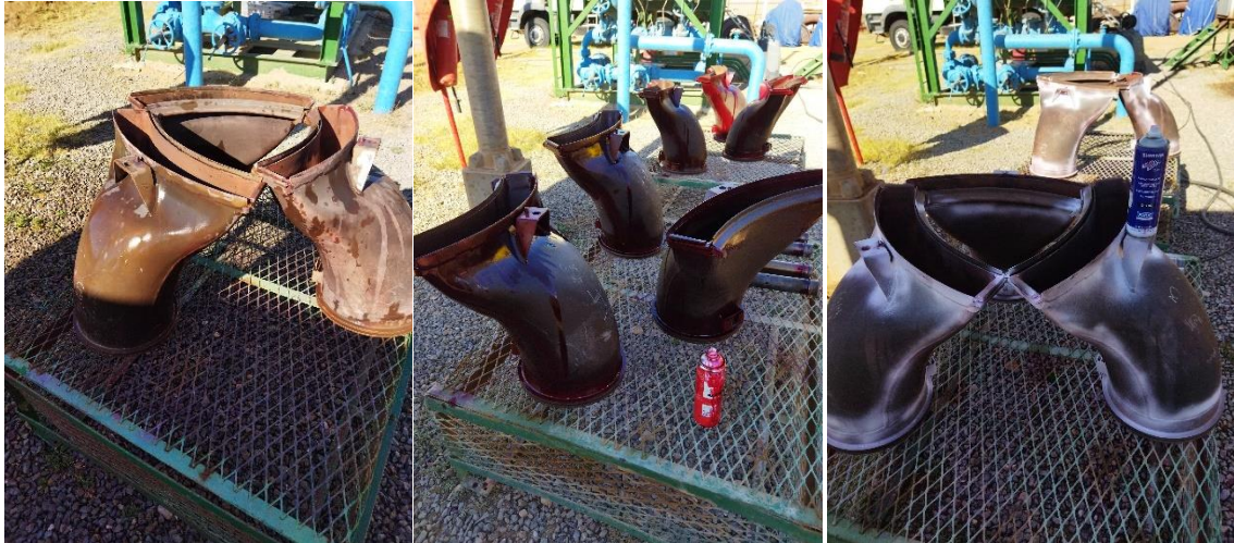
Figure III 7: Contrôle des pièces de transition
