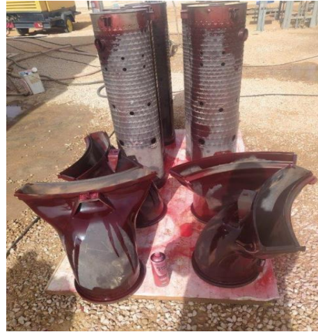
Figure III 2: Etape : application du pénétrant
