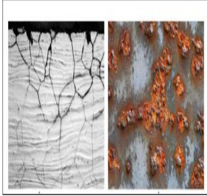
الشكل 1-4-4-التآكل الحبيبي
