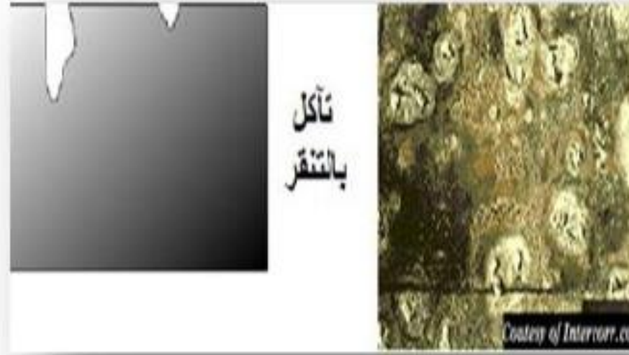
الشكل 1-2- التآكل الموضعي (بالنقر)
