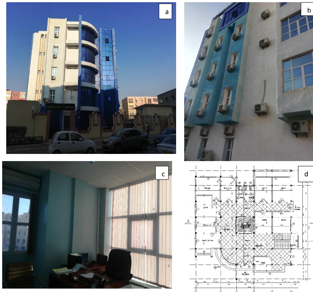
Figure V.14. Direction de la santé publique à Biskra. a : façade principale ; b : fenêtres ; c : bureaux ; d : plan RDC. (Source : Auteur, 2019)
