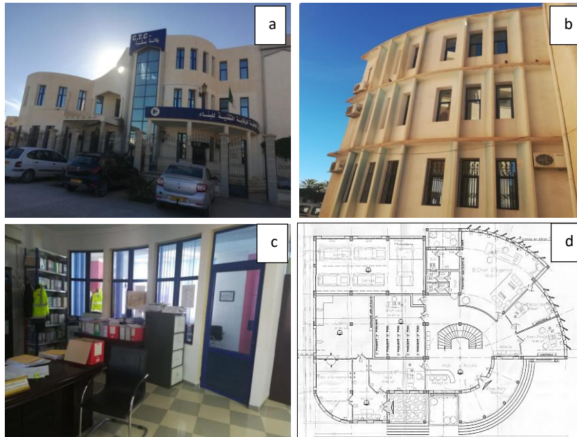
Figure V.7. Direction du contrôle technique des bâtiments Est a Biskra. A : façade principale ; b : fenêtres ; c : bureaux ; d : plan RDC. (Source : Auteur, 2019)
