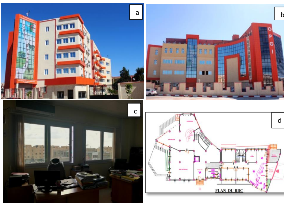
Figure V.13. L'Office de Promotion et de Gestion Immobilière a Biskra. a : façade principale ; b : fenêtres ; c : bureaux ; d : plan RDC. (Source : Auteur, 2019)
