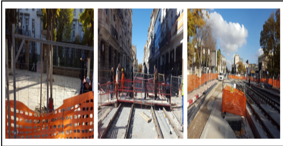
Photo IV-1 : Les différentes mesures prises pour l'installation du chantier de la première ligne du tramway de Sétif. Source : Entreprise Métro d'Alger (EMA,2015).
