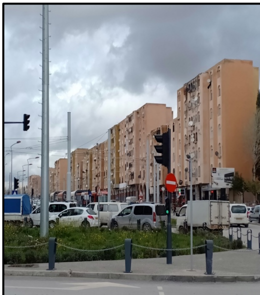
Photo VI-5 : La congestion au niveau du carrefour El Hassi vers le boulevard n°1
