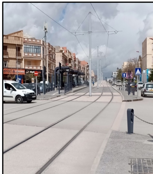
Photo VI-6 : La conservation des deux voies de circulation sur le boulevard n°1.
