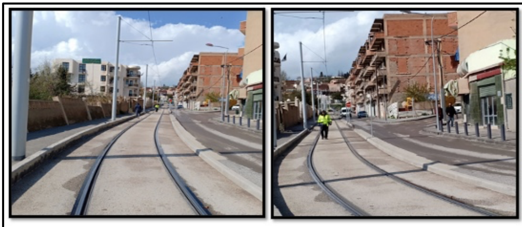
Photo VI-10 : Le stationnement au niveau de la route Targo après l'insertion du tramway. Source : Auteur,2020.
