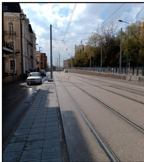
Photo VI-2 : La suppression d'un sens de circulation sur l'avenue Saïd Boukhrissa
