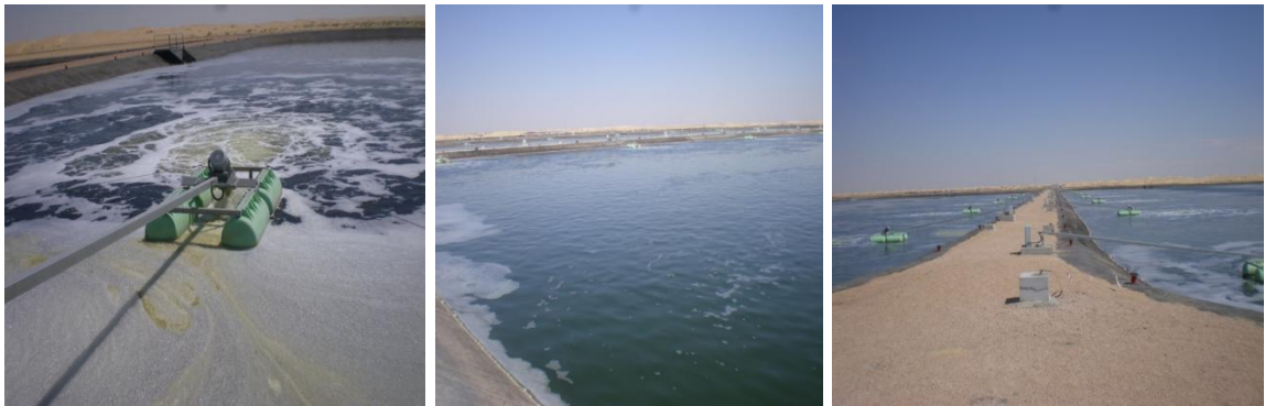
Figure 1.18. Photographies du lagunage aéré pour l'épuration des eaux usées d'Oued Souf (Dali, 2009).
