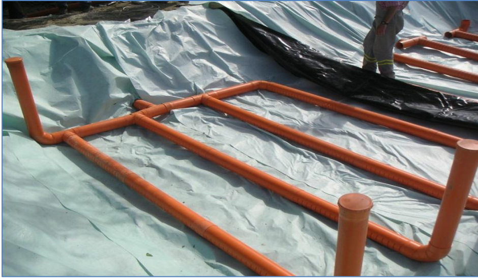
Figure IV.7. Photo d'un système d'évacuation d'un filtre vertical.
