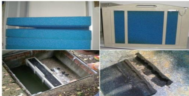
Figure IV.2. Photos représentant le filtre de finition, composé d'un porte filtre et une éponge, avant et après utilisation.
