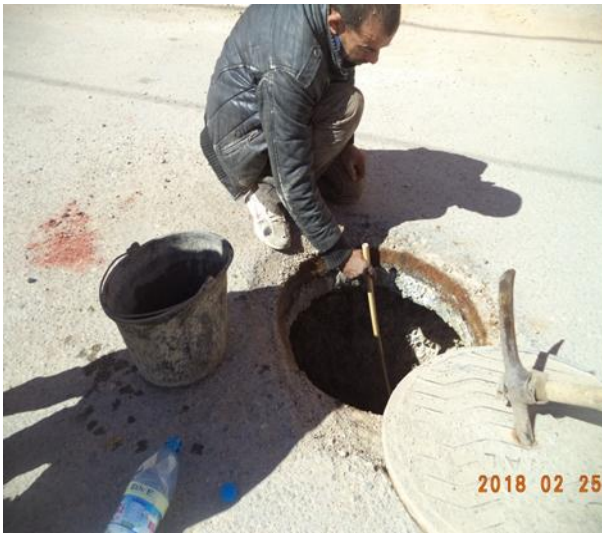
Figure II.11. Prélèvement des eaux usées.
