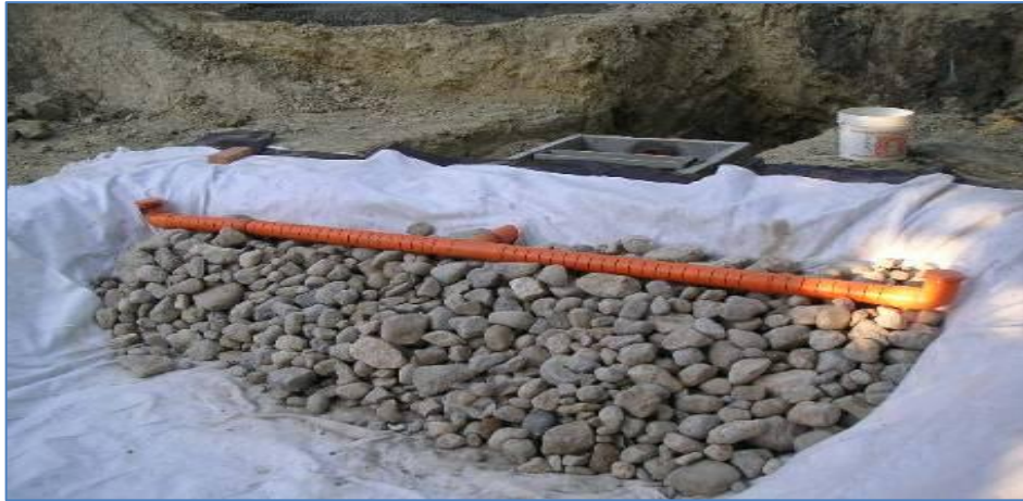
Figure IV.3. Photo d'une conduite perforée pour la distribution sous-superficielle.
