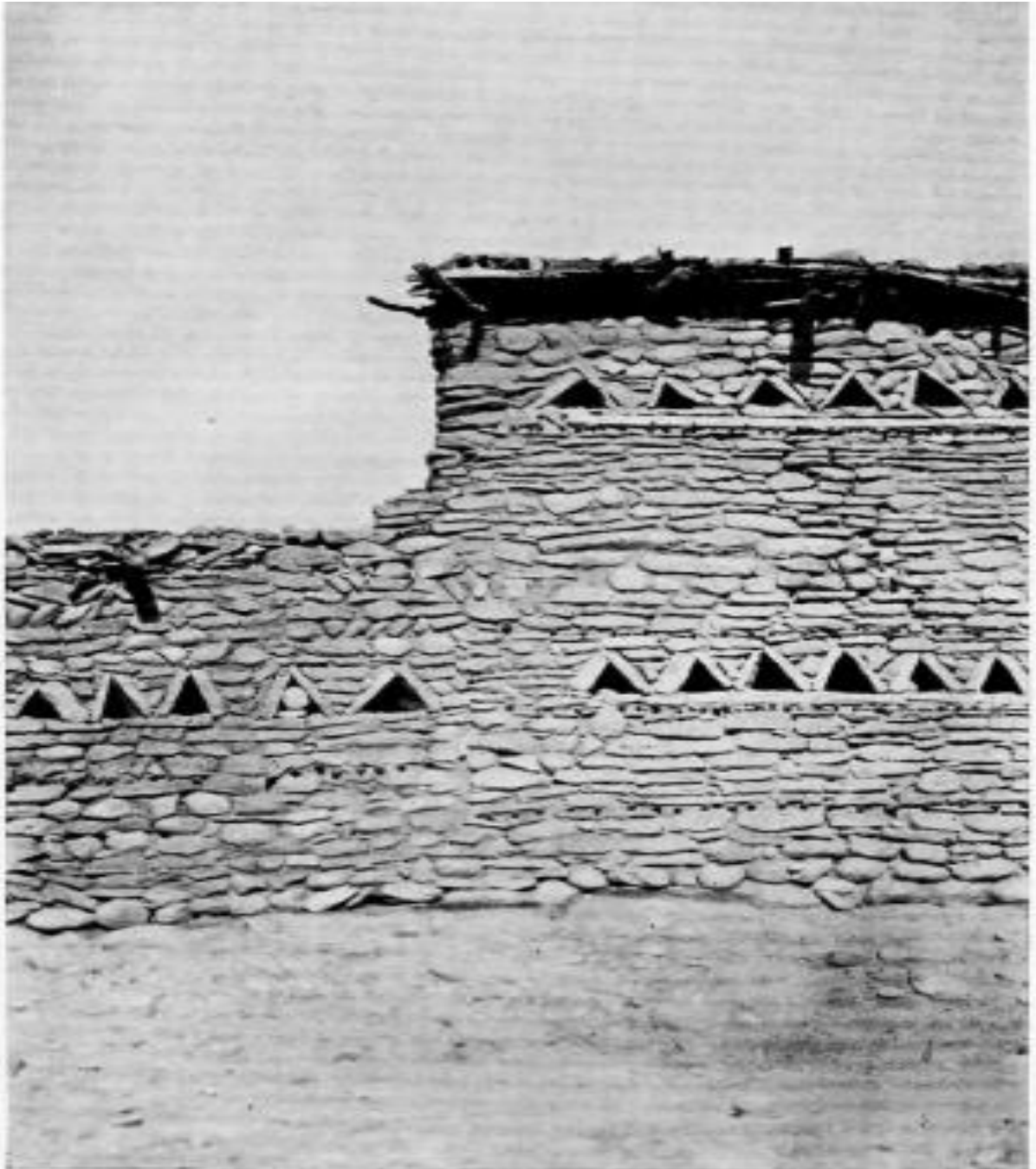
FIG. 4. — Aurès : La fenêtre chaouïa classique. Détail de construction. (Photo Mascarelli).
