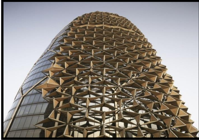
صور رقم (20) توضح مبنى مجلس أبوظبي
