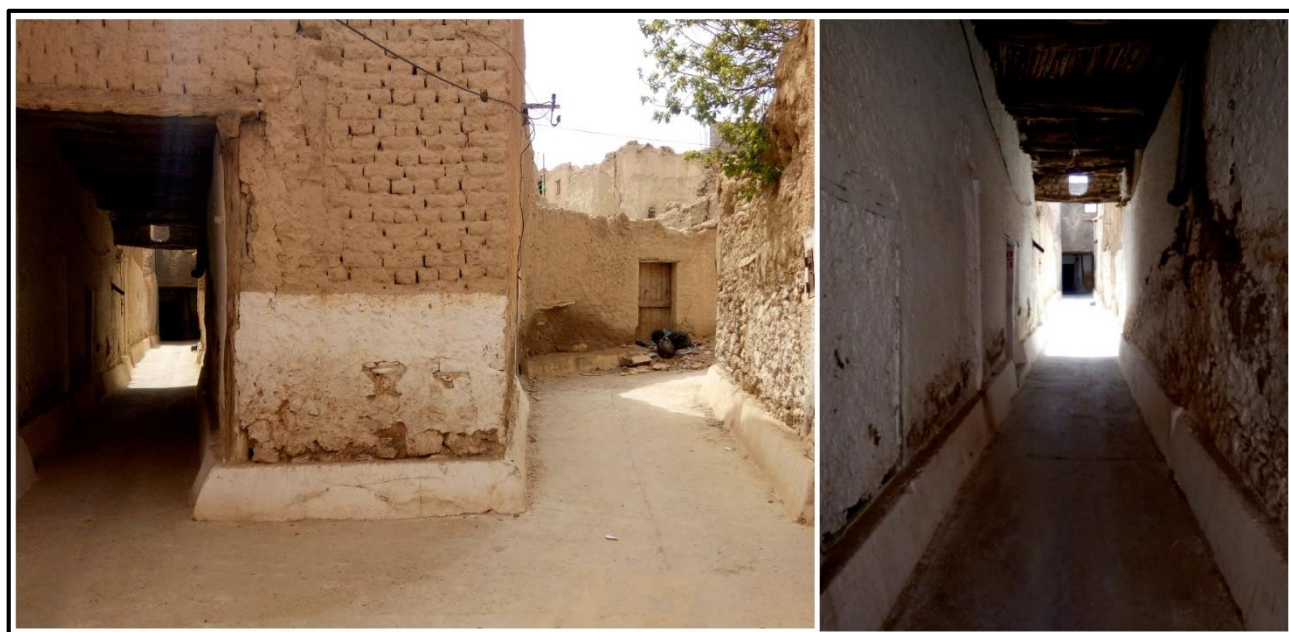
Fig.IV.10 : façades de quelques maisons de la médina de Bou-Saada qui sont dotées d'une seule porte donnant souvent sur l'impasse. Source : auteur, 2018
