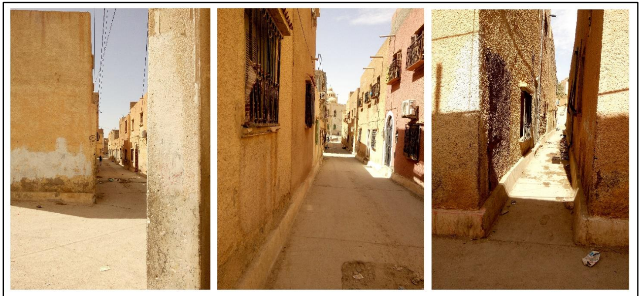
Fig.IV.30: état de constructions dans la zone 03 (Mouamine Gheraba). Source : auteur, 2023.
