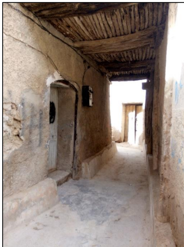
Photo IV.2 : ruelle étroite et sinueuse, avec un passage couvert (quartier d'Achacha). Source : auteur, 2023
