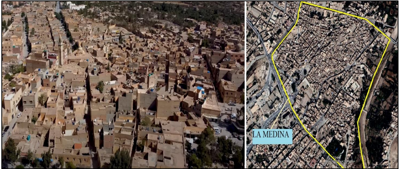
Fig.IV.11 : vues aérienne et satellitaire sur la médina de Bou-Saada. Source : Khoubaib, et Google Earth (2023)
