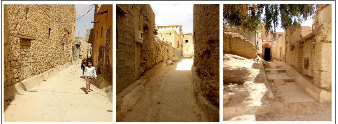
Fig.IV.29: état de constructions dans la zone 01 (El-Ksar). Source : auteur, 2023.
