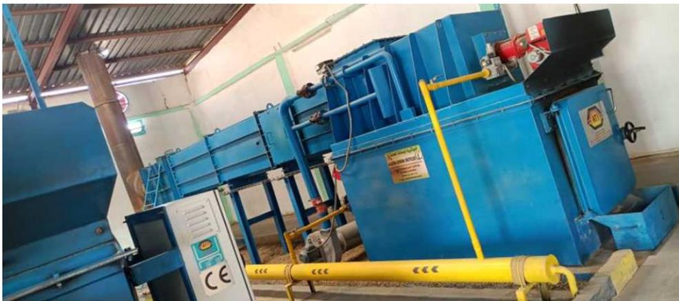
**Figure 21.** Incinérateur utilisé dans la zone Sidi Okba (Original, 2024).
