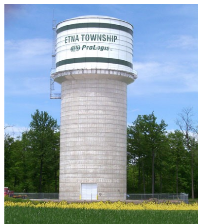
Réservoir surélevé Château d'eau
