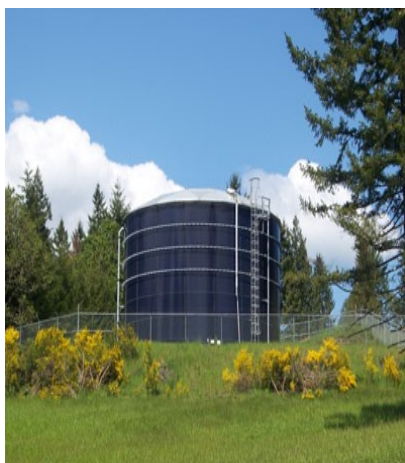
Réservoir circulaire semi enterré
