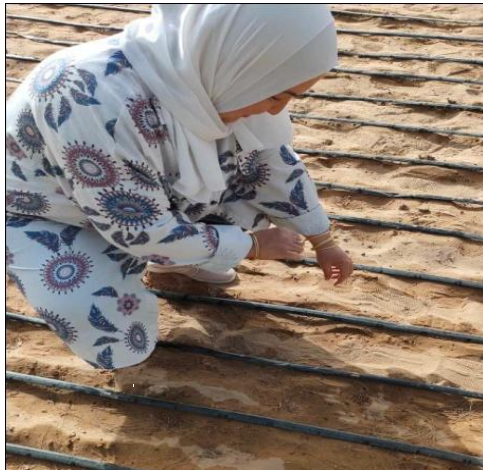
Photo 13: Piquetage et traçage des parcelles élémentaires
