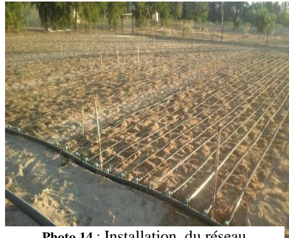
Photo 14 : Installation du réseau d'irrigation goutte à goutte
