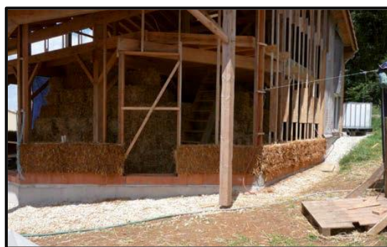
Figure 19 : Premier rang de bottes de paille monté selon la technique CST, à l'extérieur d'une structure poteau poutre.
