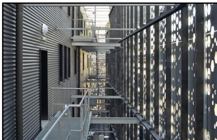
Figure 51 : une double peau métal suspendu à la toiture.
