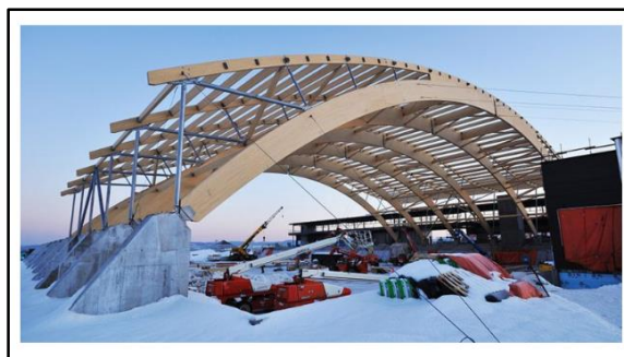
Figure 13 : des éléments courbes en bois Lamellé-Collé.
