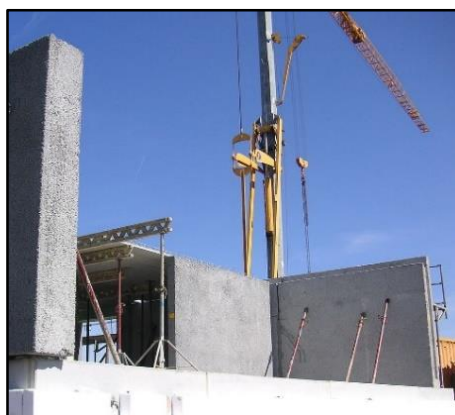
Figure 22 : murs en béton léger
