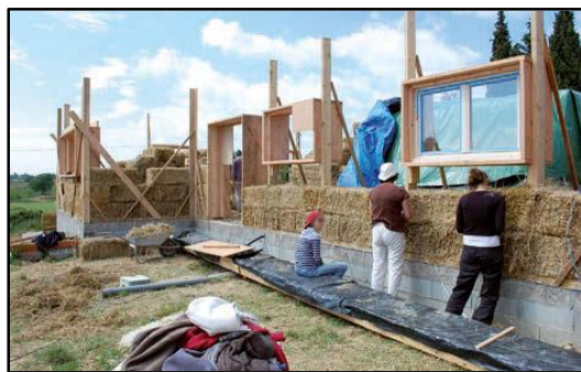
Figure 16 : techniques de construction en bottes de paille.
