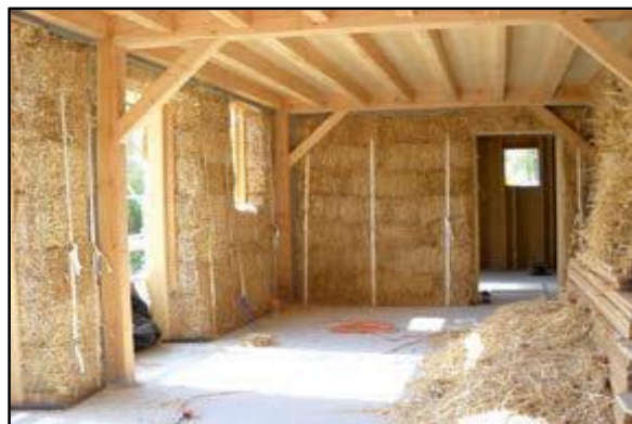
Figure 17 : la technique bois et paille.
