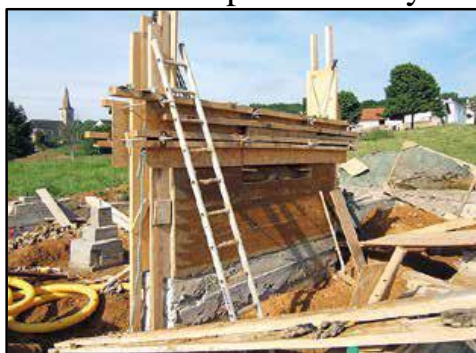
Figure 2 : mur monolithique en pisé.
