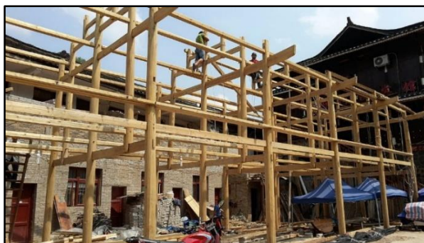
Figure 11 : construction à ossature bois.
