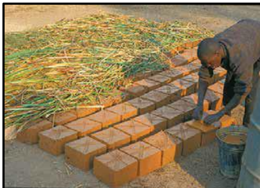
Figure 5 : L'adobe ou brique de terre moulée (BTM)
