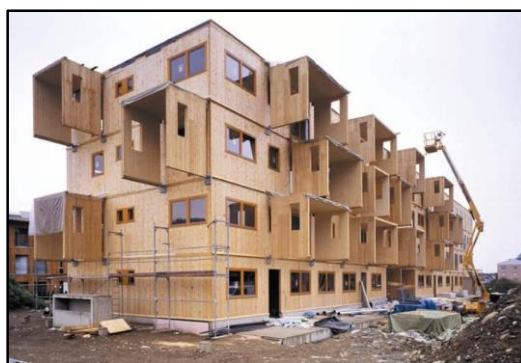
Figure 12 Construction de bâtiments avec des panneaux de bois massif.
