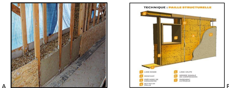
Figure 18 : détail construction avec la technique du Greb .
