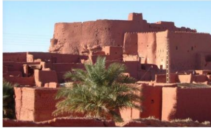
صورة رقم (12) : قلة الفتحات في واجهات المبنى الخارجية _ تميمون
