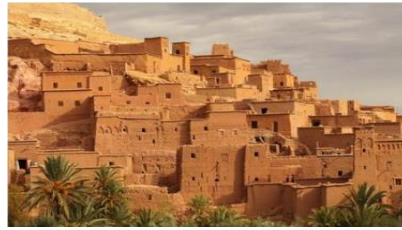
الصورة رقم (14) : قصر ايت بن بورزازات حيث تظهر نسبة مساحة الفتحات قليلة بالنسبة لمساحة الواجهات المعرضة للشمس
