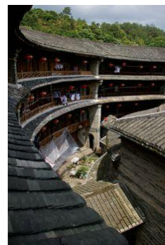
Figure 40 : Tulou du Fujian
