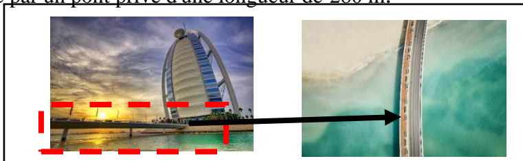
Figure 29 : le pont privé de l'hôtel
