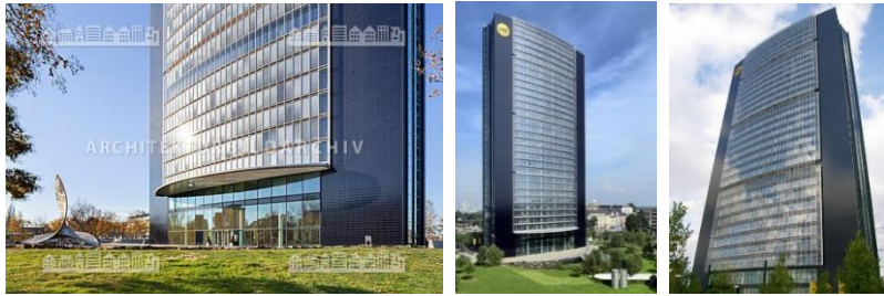
الصورة (أ-14). واجهة الهياكل الصندوقية في المبنى الإداري (ARAG– Versicherugt ألمانيا) المصدر: skyscrapercenter.com
