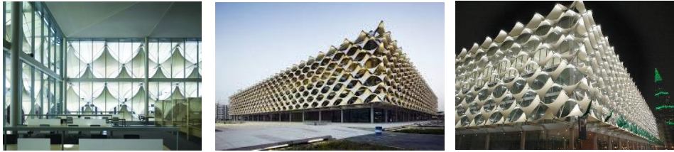
الصورة (1- 22). استخدام النسيج في واجهات مكتبة الملك فهد الوطنية، المملكة العربية السعودية
