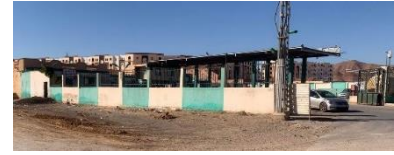
الصورة (II - 30). محطة البنزين (الباحثة 2023)
