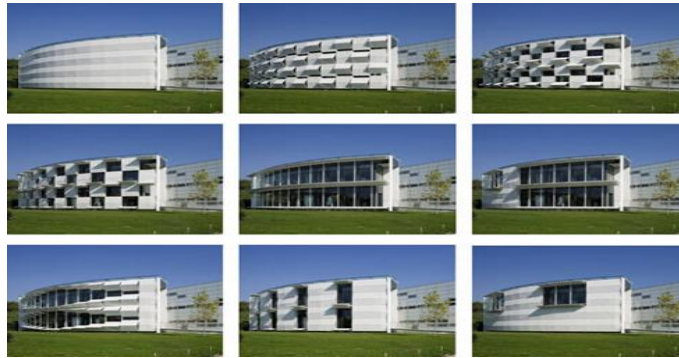
الصورة (1- 21). الوضعيات المختلفة التي تأخذها الواجهة الديناميكية للمبنى
