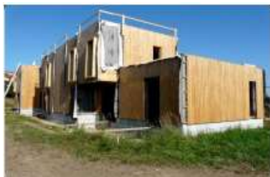
صورة 52: الهيكل الخشبي
