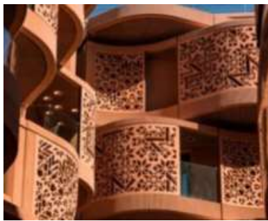
صورة 41 : توضح استعمال المشربية في المنزل كالتنظيم للتبريد
