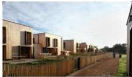
صورة 50: الهيكل الخشبي
