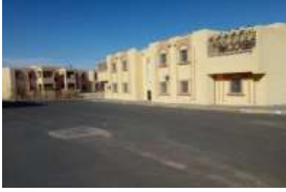
الصورة 04: سكن نصف جماعي ورقلة العالية المصدر: الباحثة
