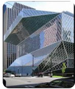
Figure4.1 : la bibliothèque de Seattle Source : Google image
