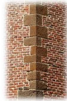
FIGURE 1.6 : L'ENVELOPPE EN REMPLISSAGE MAÇONNE SOURCE : https://fr.wikipedia.org
