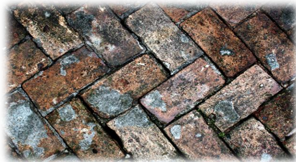
FIGURE 1.20 : APPAREILLAGE EN BRIQUE
