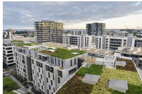
الصورة 7: أسطح خضراء
