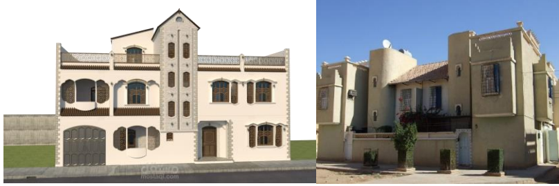
الصورة 15، 16: سكنات فردية
