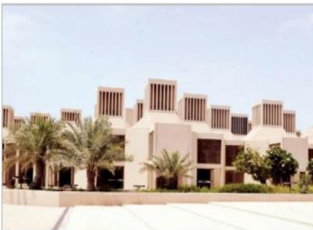
الصورة 38: ملقف بمبنى جامعة قطر بالدوحة.
