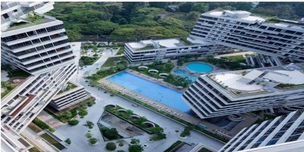
الصورة (I-4): أماكن الجلوس والمساح
