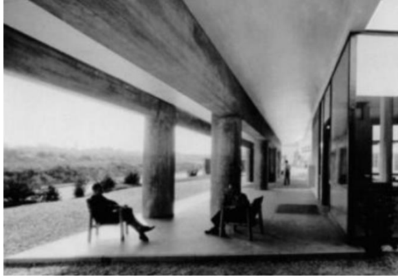
الصورة (I-1): le 6e façade du pavillon suisse 1933
