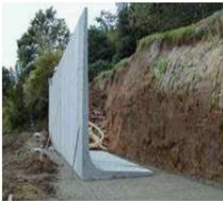
Figure1- 4 :Murs cantilever en béton armé
