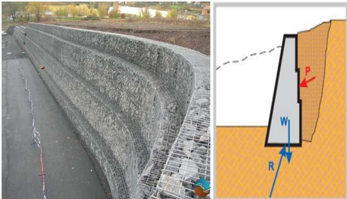
Figure 1.2 : Exemple de mur poids formé de gabion
