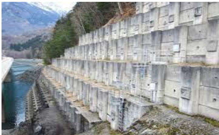
Figure 1.7 : mur de soutènement- murs ancrés
