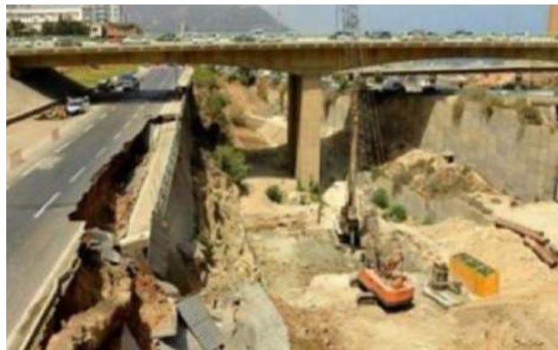
Figure I.14 : Rupture rotationnel avec fissuration[4]
