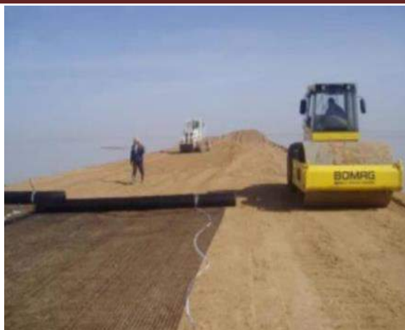
Figure II.10 : Installation d'une géogridle (Berrabah et al 2020).
