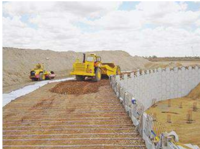
Figure II.8 : Chantier de montage de murs en sol renforcé (Terre Armée)[21]
