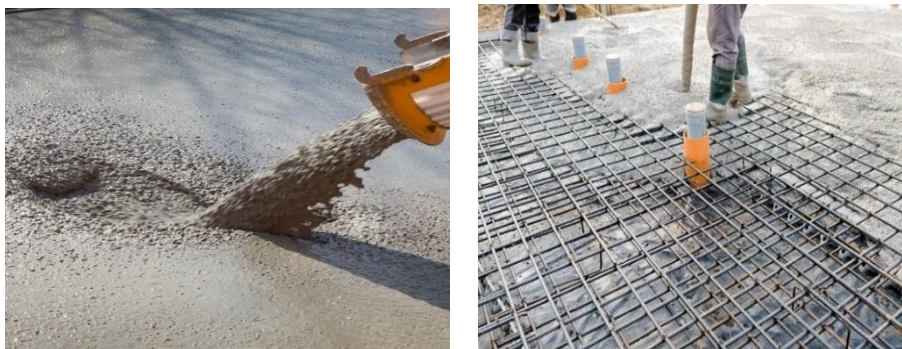
Photo 1-1 : Le béton autoplaçant
