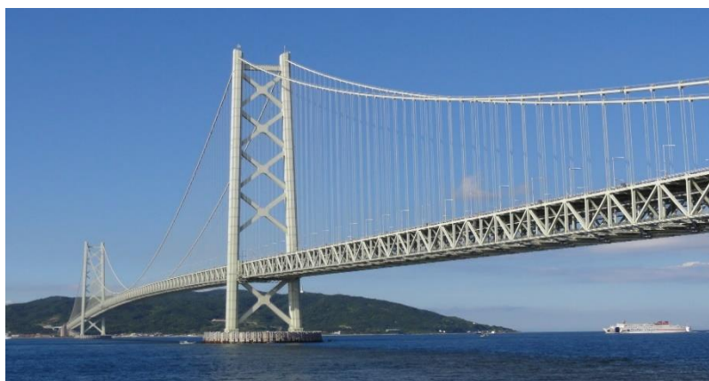
Photo 1-2 : Le pont Akashi Kaikyo
