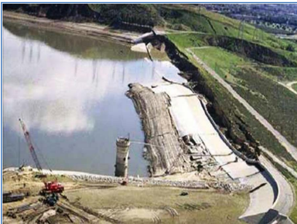
Figure 2.9 : Barrage inférieur de San Fernando après le séisme de 1971. [11]
