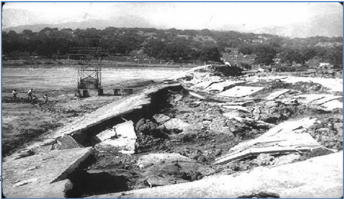
Figure 2.11 : Rupture du Barrage de Sheffield de Santa Barbara [11].
