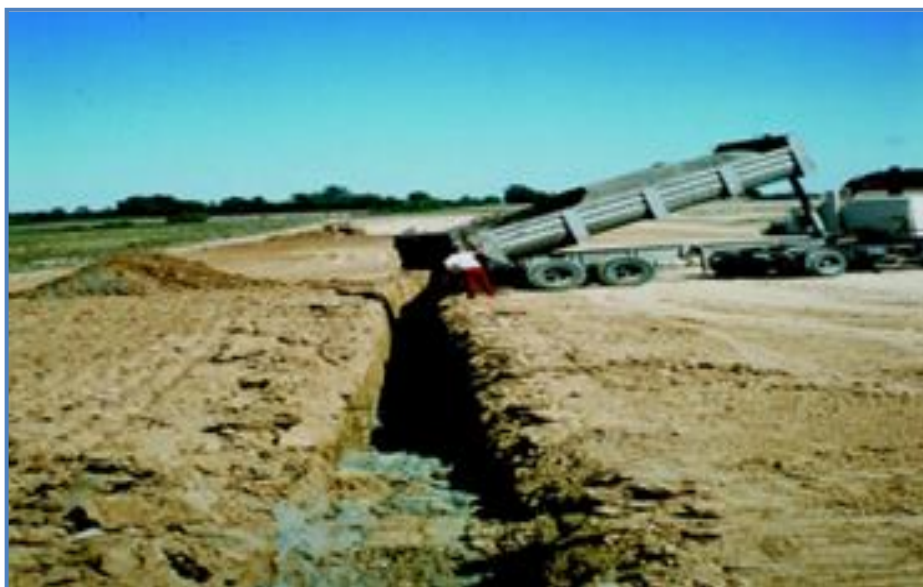
Figure 1.5 : Drain vertical recreusé dans le remblai et remplissage par du sable drainant et auto filtrant[2].
