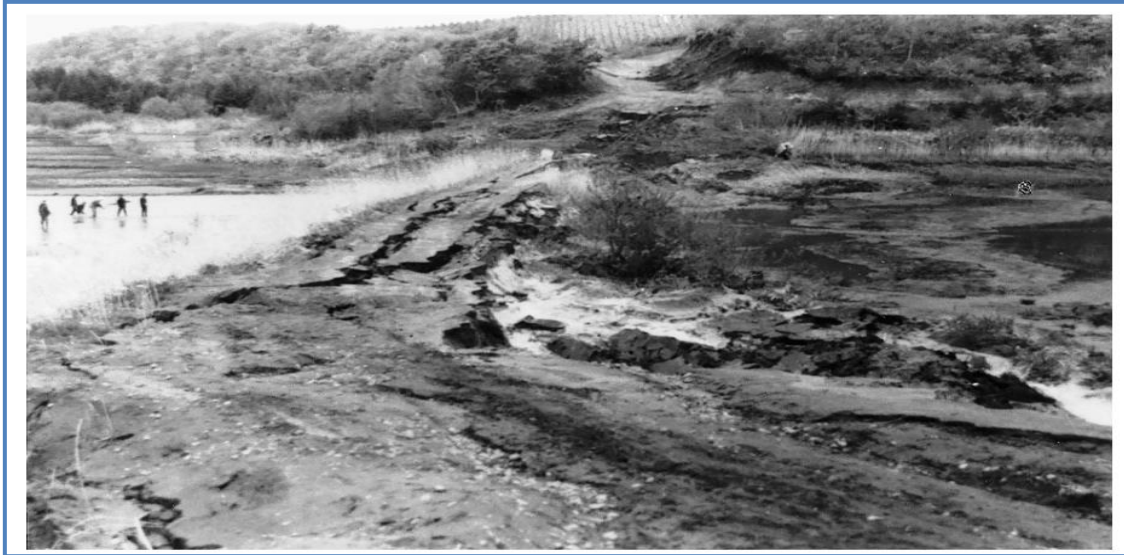
Figure 2.12 : Rupture du barrage de Yamanaka, JAPON 1968. [14]
