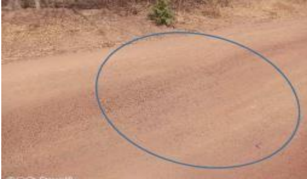
Figure I.10: Affaissement
