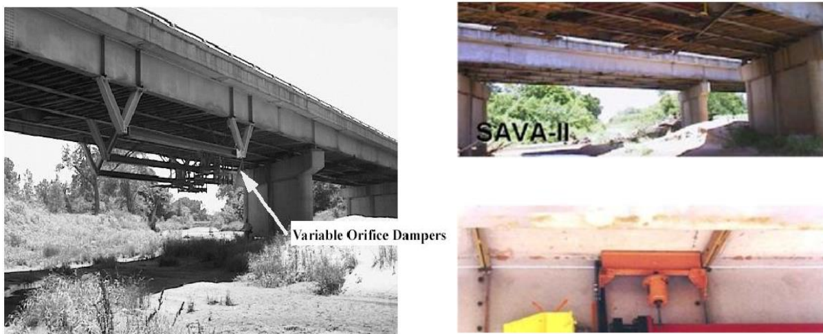
Figure 1.9 Première mise en œuvre à grande échelle de l'amortissement intelligent aux États-Unis et des amortisseurs à orifice variable [13]
