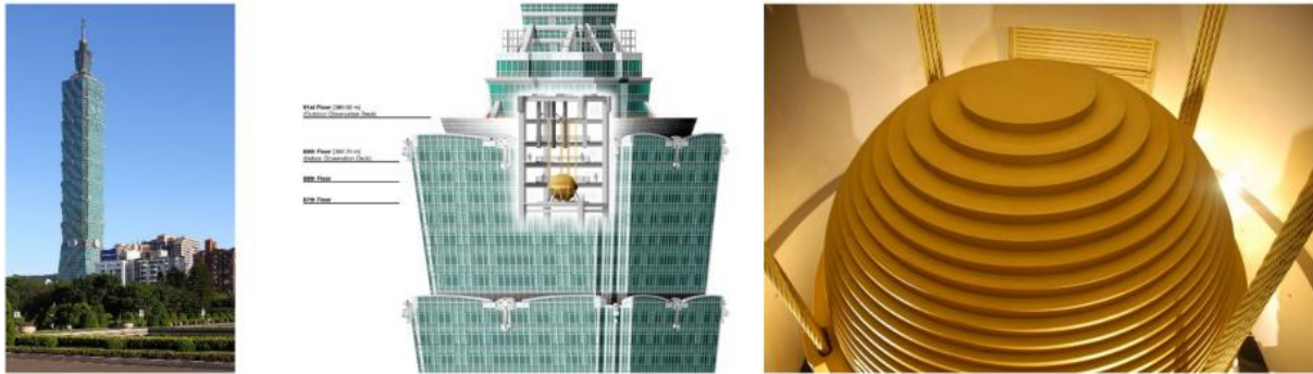
Figure 1.23 L'amortisseur TMD installé au sommet de la Tour de Taipei 101 à Taiwan [10]
