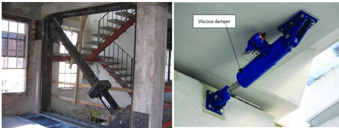
Figure 1.19 Amortisseur visqueux [26, 27]
