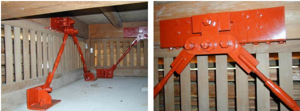
Figure 1.18 Amortisseur viscoélastique (VE)
