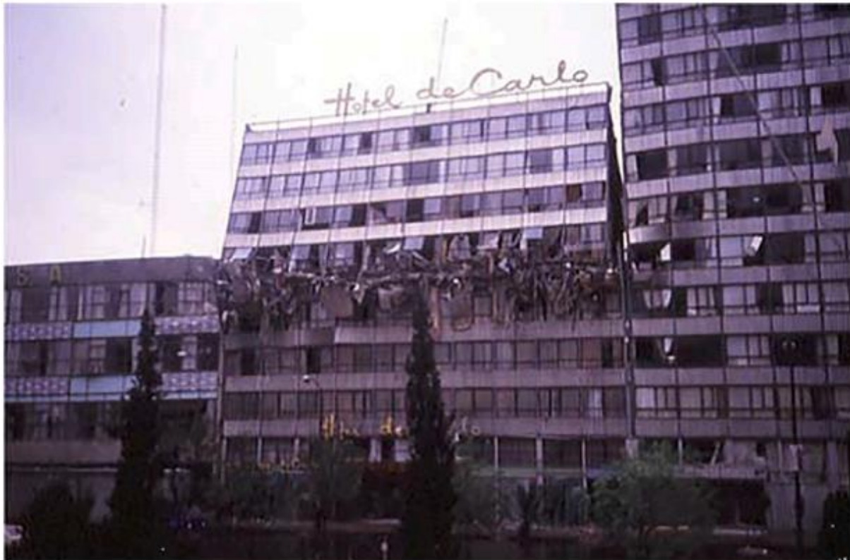
Figure 2.3 Bâtiments endommagés par l'entrechoquement du séisme de 1985 à Mexico [34]
