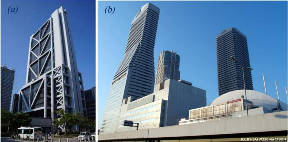
Figure 1.5 (a) Rokko Island Procter and Gamble équipé d'un ATMD, Kobe, Japan; (b) ORC 2000 Symbol tower équipé d'un ATMD, Osaka, Japan [11]
