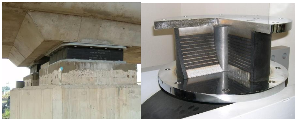
Figure 1.16 Isolateur en Élastomère avec Barreau de plomb (LRB)
