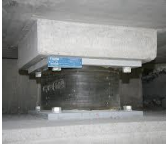
Figure 1.17 Isolateur en Élastomère d'amortissement élevé (HDR)
