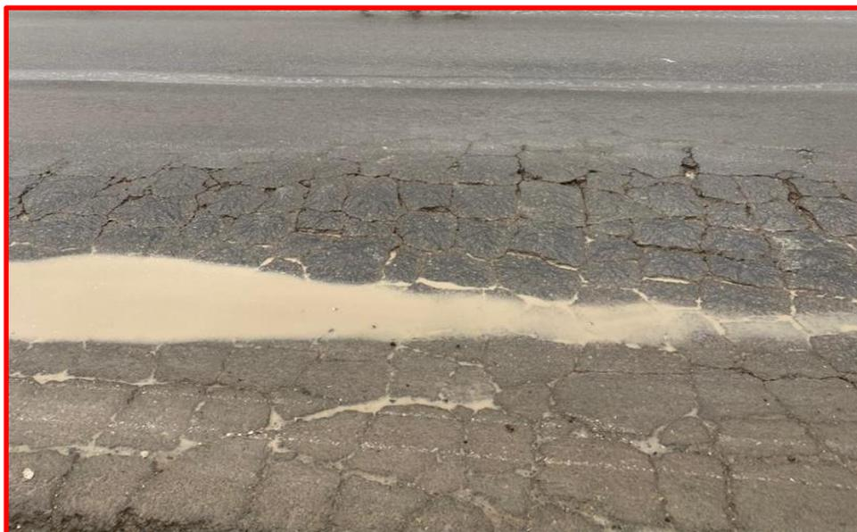
Figure I. 10: Dégradation de la Route Existante
