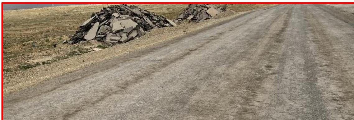
Figure I. 12: Scarification de la Chaussée
