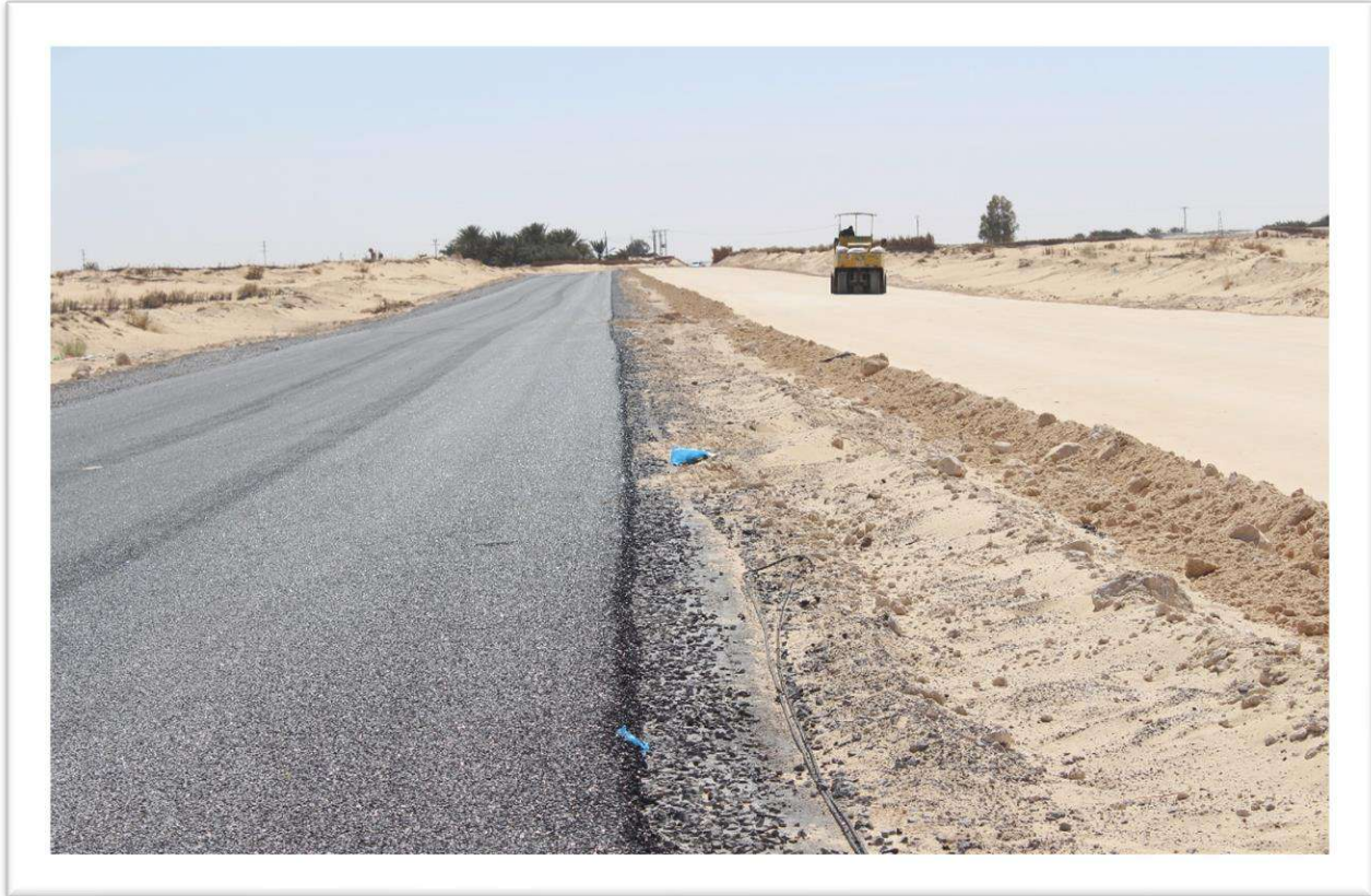
FIGURES1-3 : PHOTO DU CHANTIER
