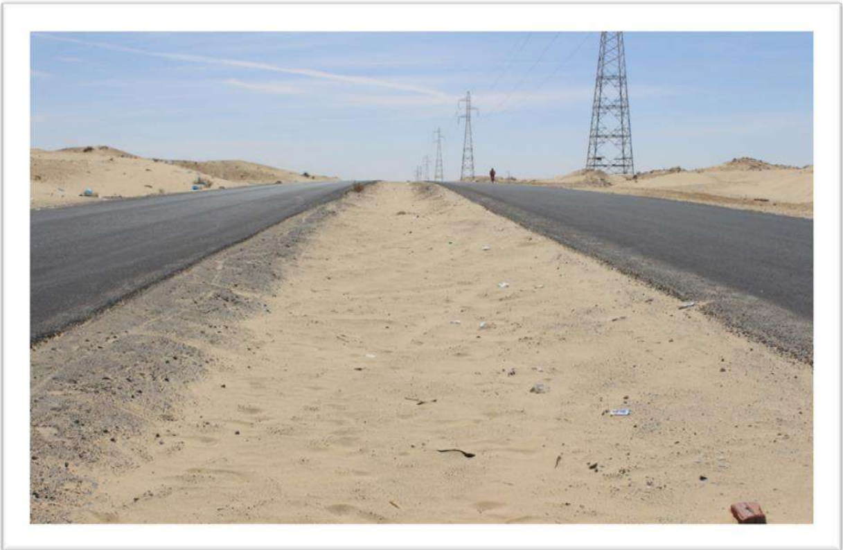
FIGURES1-6 : PHOTO DU CHANTIER
