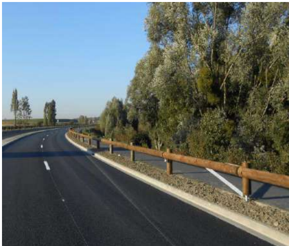
Les glissières en bois
