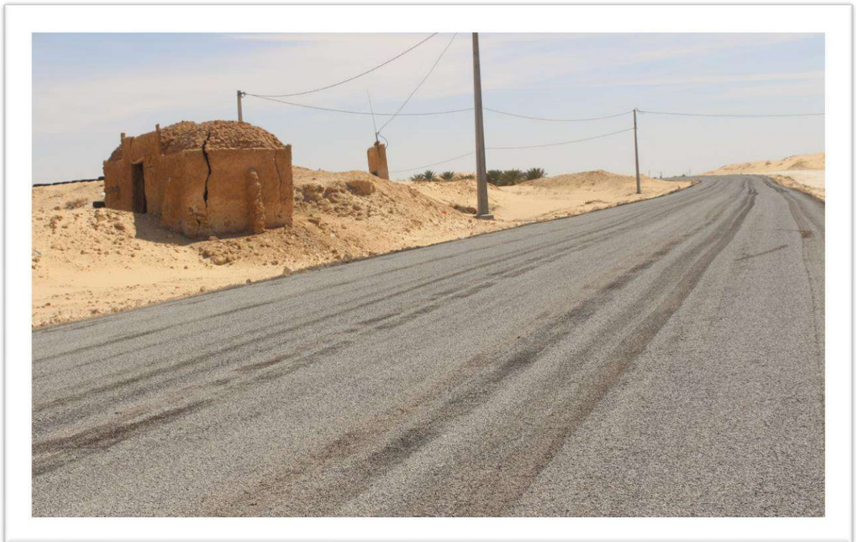
FIGURES 1-5 : PHOTO DU CHANTIER
