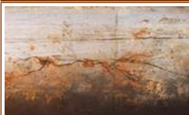
الشكل (1-6): التآكل الإجهادي [7].
