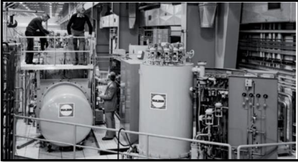
الشكل (10.III) ثلاجات بقدرة 400w عند 4.5 كلفن (Sulzer) لتشغيل المغنطيسات كاشفات الجسيمات في منطقة الشمالية لـ CERN في سنوات 1970.
