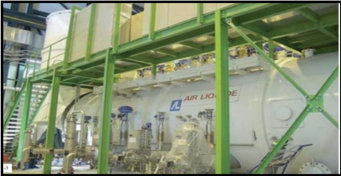
الشكل (11.III) ثلاجات 18Kw عند 4.5 كلفن Air liquid المعجل بالموجات الدقيقة في مختبر التسريع المتصادم الهدرونات الكبير في LEP.
