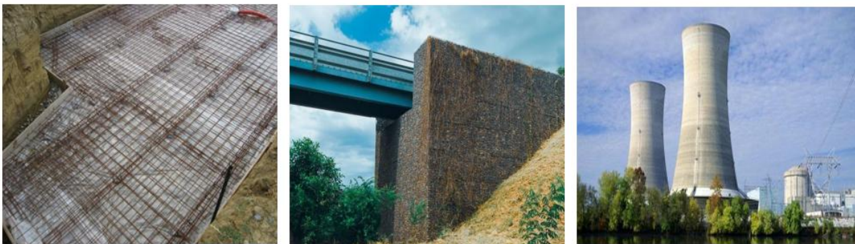
Figure 8.4 : réalisations en béton lourd
