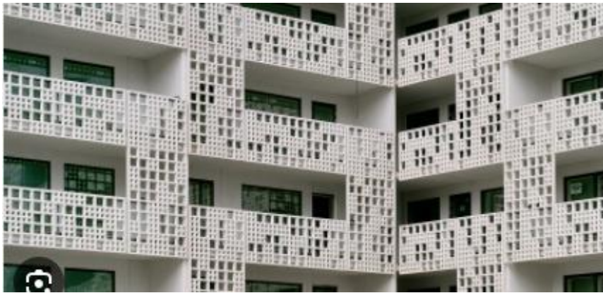
Figure 4.6 : façades en béton fibré Maroc
