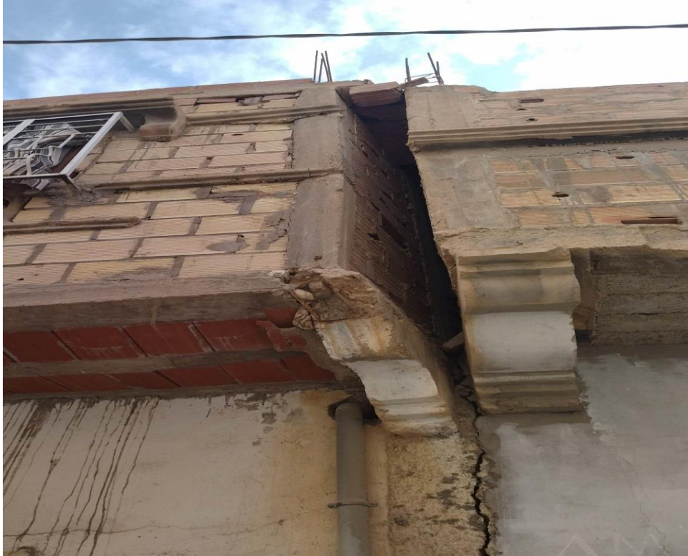
FIGURE 21 LA CONSTRUCTION ANARCHIQUE COMME RESPONSABLE DE LA DEGRADATION A HAI BOUASSID
