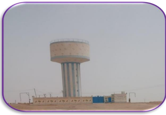
الصورة (2-7):خزان ماء،
