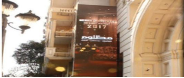
صورة 5 مشكلة موقع وحدة الاعلان على واجهة مبنى سكني
