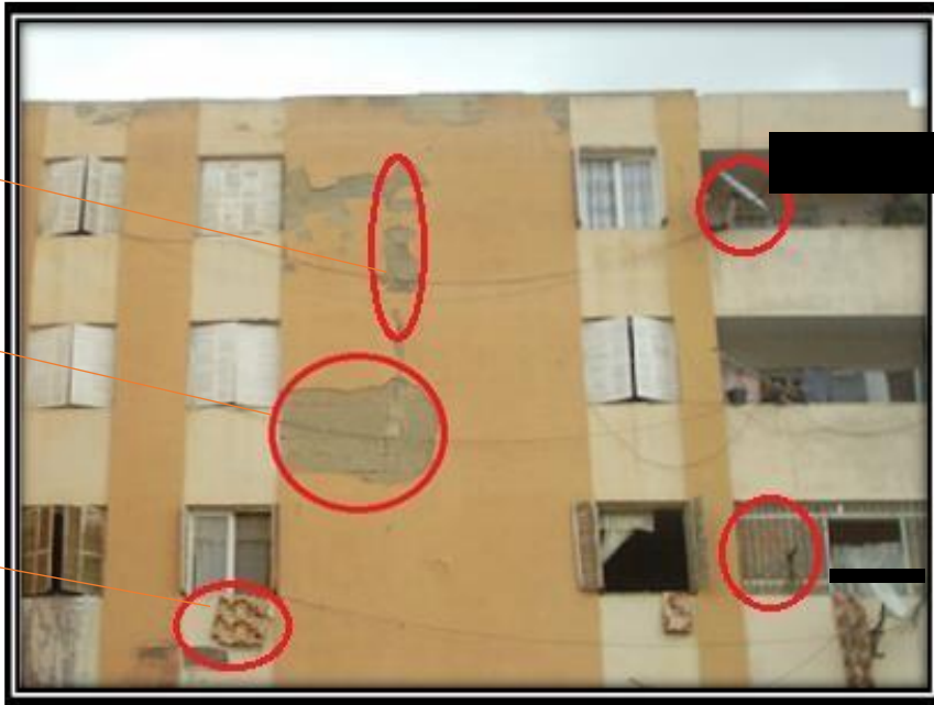
الشكل رقم 13 بناية جدرانها مشققة.
