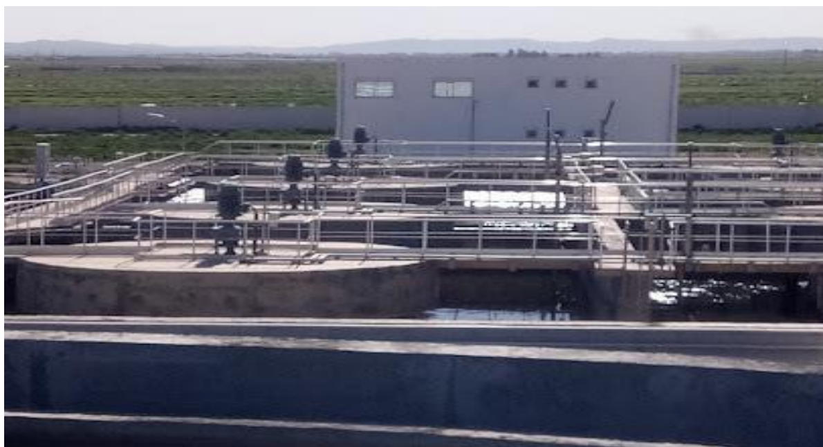
Figure I.10 : station d'épuration (Ain Zerroug) Tébessa
