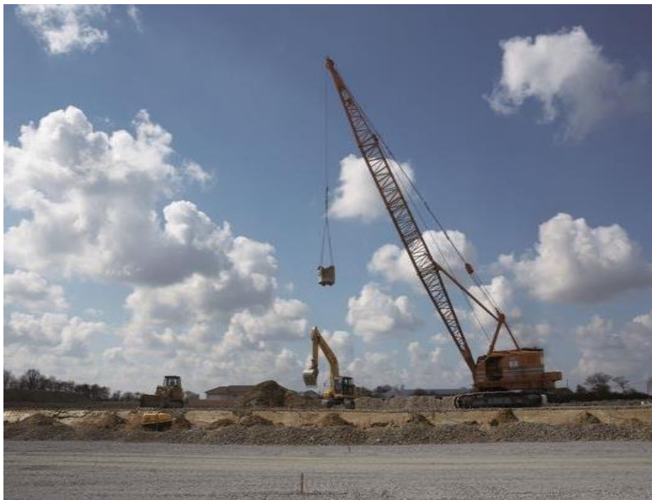
Figure1-10 : Engin utilisé pour la réalisation des plots ballastés
