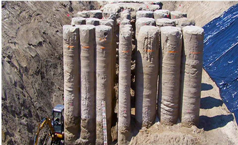
Figure 1-1 : Réalisation d'une colonne de jet
