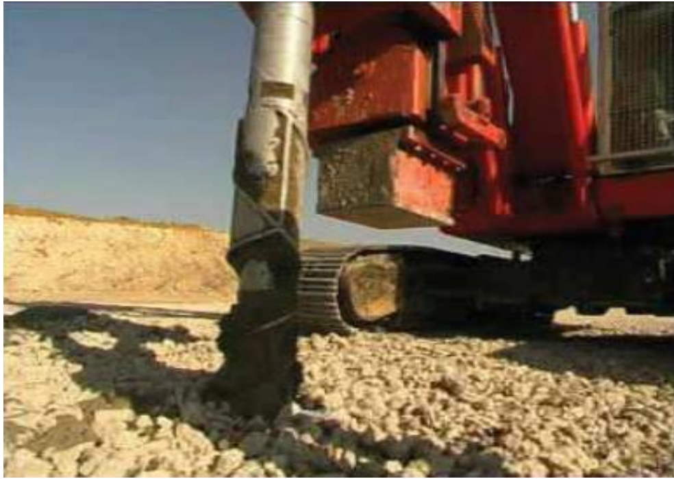
Figure 1-3: Réalisation de colonnes à module contrôleur
