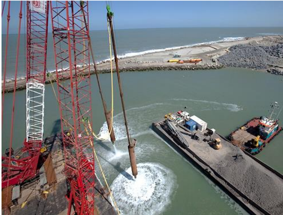
Figure 1-12 : Chantier des colonnes ballastées dans la mer
