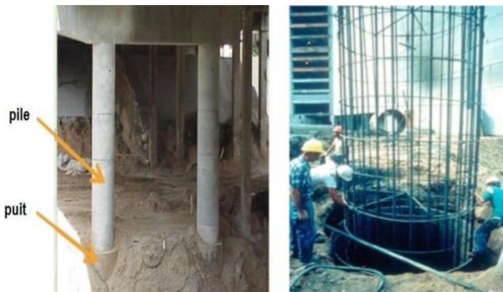
Figure 1-10: Exemple de réalisation des fondations semi-profondes
