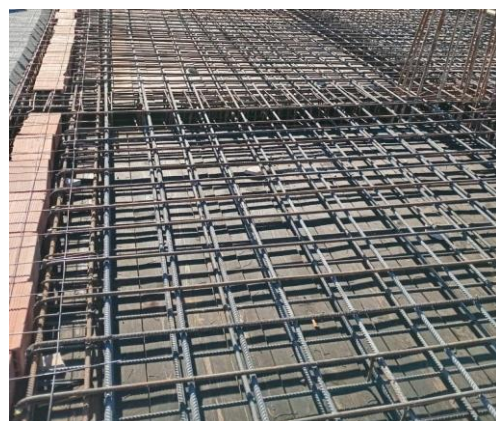
Figure.1.41. Pose du treillis soudés.
