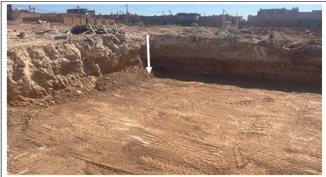
Figure.1.22. Mesure de la profondeur de fouille (bon sol).
