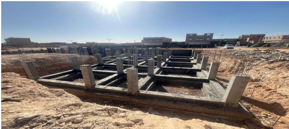
Figure.1.27. fin de coulage de semelle pour trouve les pertes (béton et coffrage)
