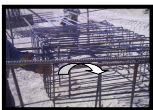
Figure.1.19. Recouvrement des barres.
