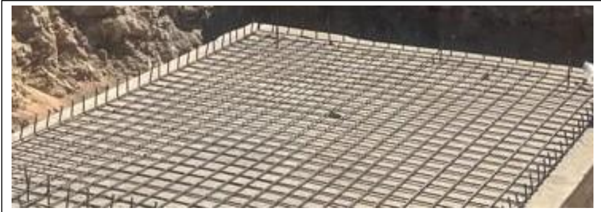
Figure.1.25. Mettre Les écarteurs.
