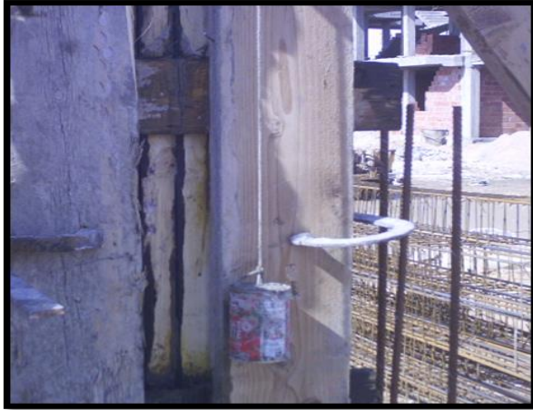
Figure.1.35. Contrôle de verticalité
