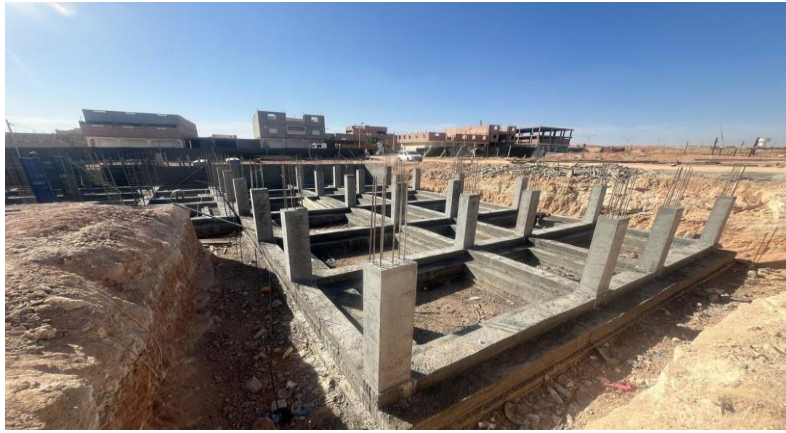
Figure.1.28. Coffrage et coulage bien de l'amorce poteau.
