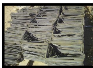
Figure.1.20. Préparation des cadres
