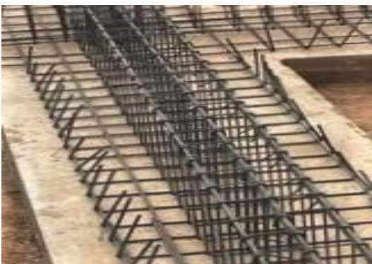
Figure.1.29. Ferrailage et coffrage la longrine.
