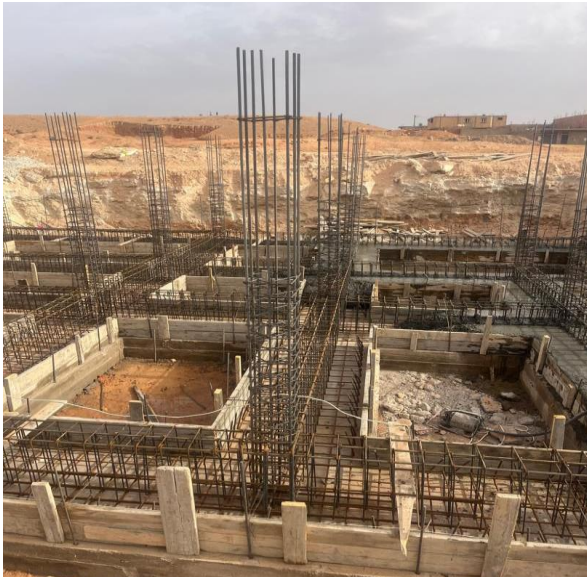
Figure.1.26. Coffrage et Coulage de semelle par la grue.
