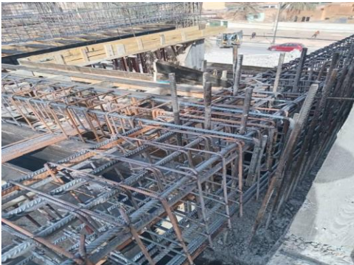
Fgure.1.44. Ferrailage des poutres
