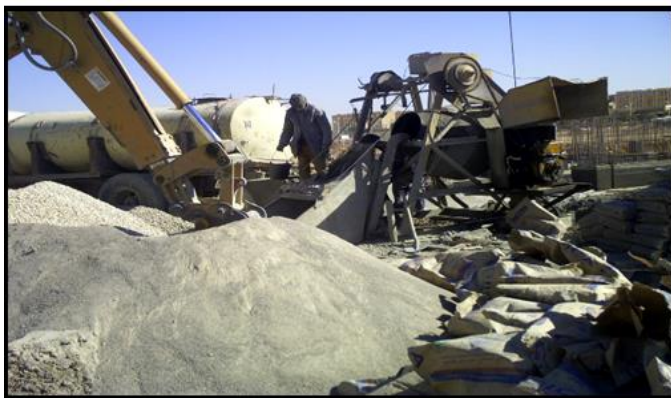
Figure.1.15. Espace de préparation du béton.
