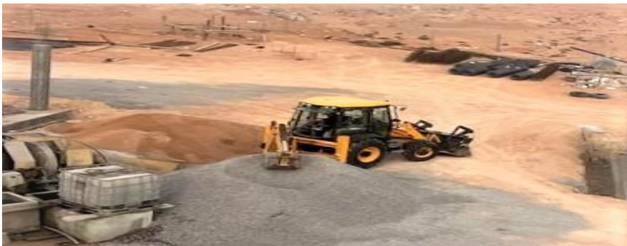
Figure.1.6. la pelle mécanique pour le terrassement ou transport les matériaux.
