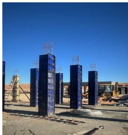
Figure.1.34. Coffrage bien réglai.
