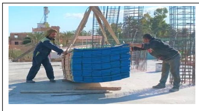
Figure.1.21. Stockage des panneaux de coffrage
