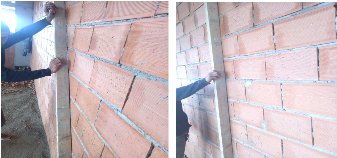
Figure 1.47: vérification de la planéité de Mur en maçonnerie
