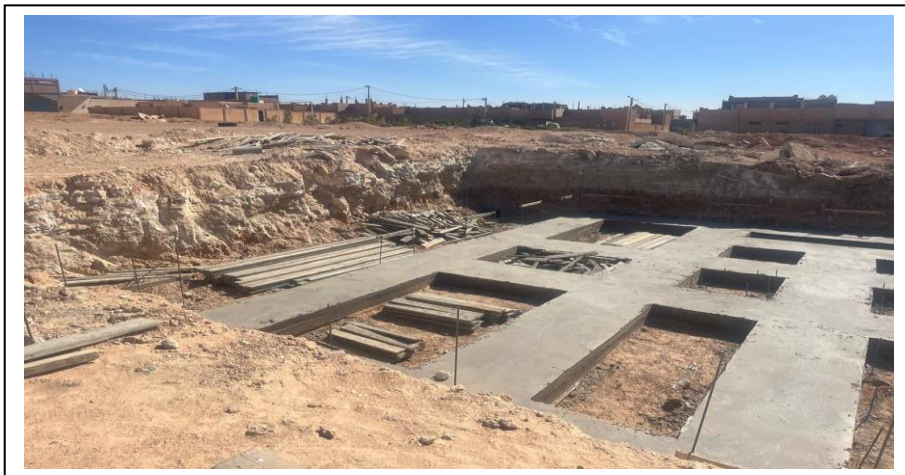
Figure.1.24. Gros béton.
