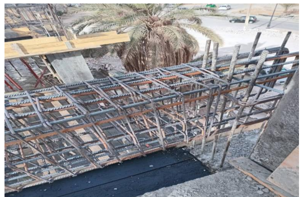
Fgure.1.44. Ferrailage des poutres
