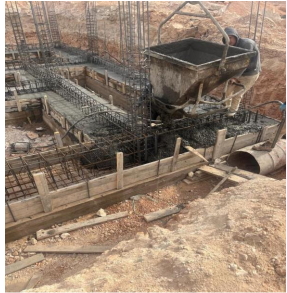
Figure.1.26. Coffrage et Coulage de semelle par la grue.
