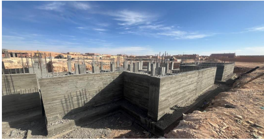
Figure.1.39. Décoffrage de voile.
