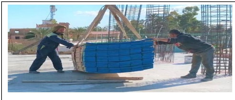
Figure.1.11. Travaux Préparatoires de coffrage (les Panneaux).
