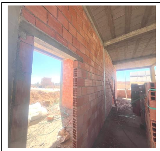
Figure1.46 : La maçonnerie et la vérification de la verticalité des parois
