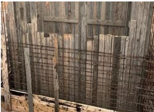
Figure.1.37. Ferrailage de voile.
