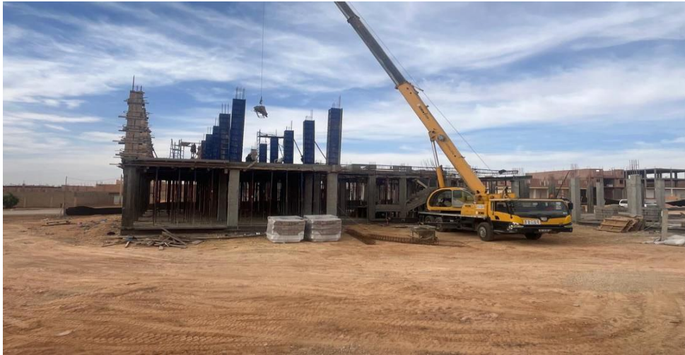
Figure.1.5. La grue de chantier pour le transport du béton et matériaux.
