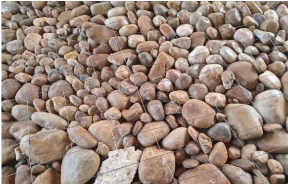
Figure.1.31. Pose le hérissage nage et le treillis soudé
