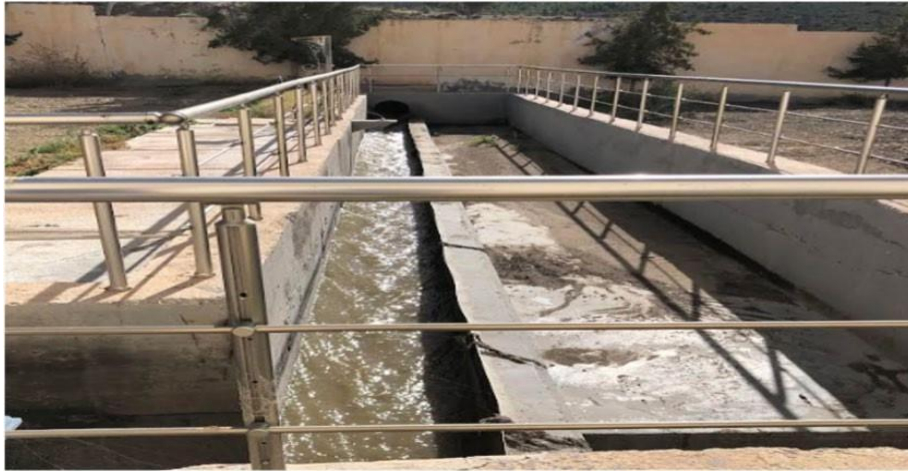
Photo III.3: Déversoir d'orage de la station d'Arris.
