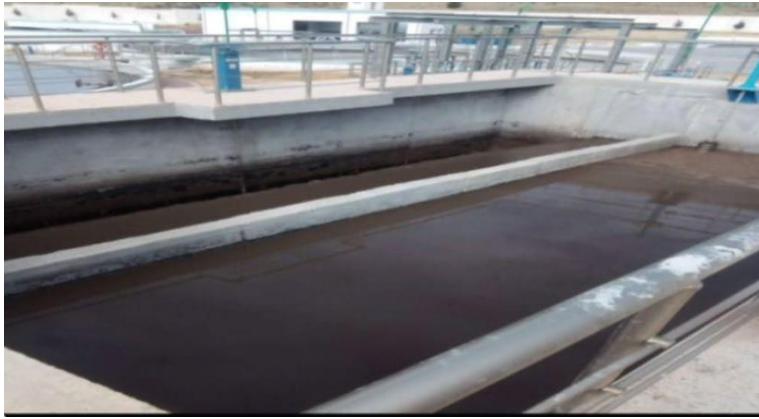
PhotoIII.10 : Dégazage de la STEP d'Arris.
