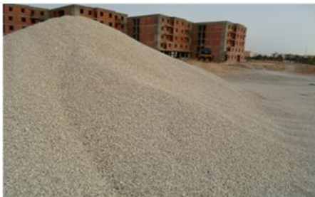
Les granulats : Le stockage de granulat dans le chantier.
