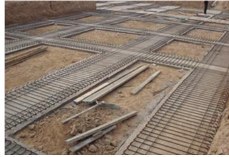
Le ferrailage de fondation
