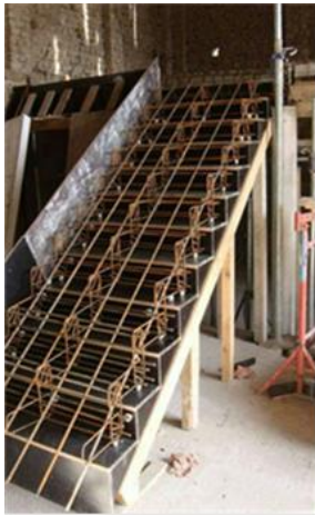
Le ferrailage Le coffrage et coulage de L'escalier
