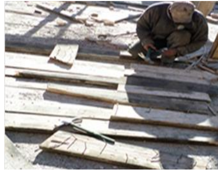
Post de coffrage
