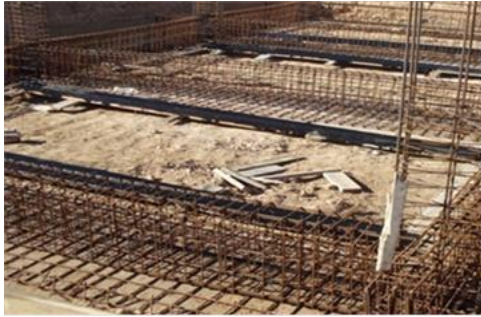
Le ferrailage de fondation
