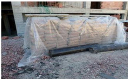
Le Ciment : le stockage de ciment dans le chantier.
