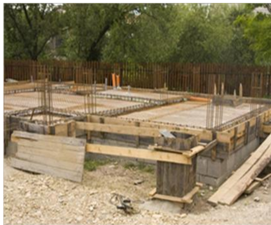
Coffrage des semelles
