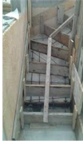
Le ferrailage Le coffrage et coulage de L'escalier
