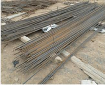
Poste de ferrailage
